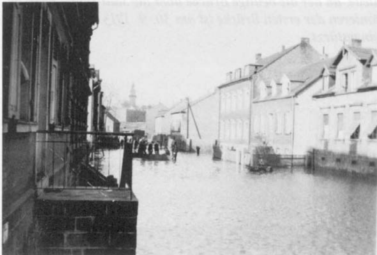
Hochwasserkatastrophe im Dezember 1947 Hier die Saarstraße im „Alten Brühl“
