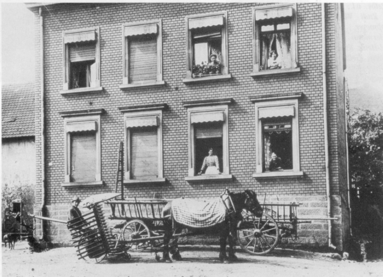
Haus Philipp Wagner, Fürstenhausener Straße 6, erbaut 1900
