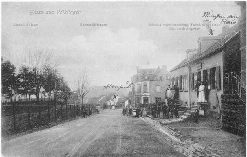
Blick von der Anböbe auf die abfallende Straße (vor 1915)
