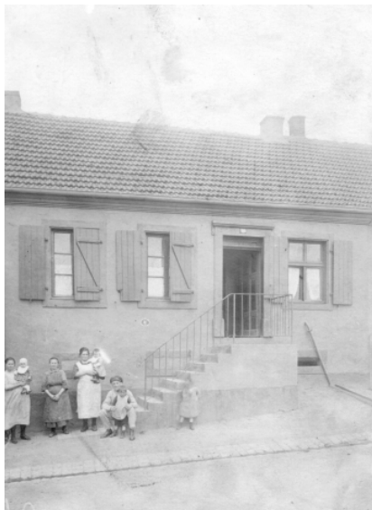
Gerhardstraße – Haus Balzer Foto: Archiv Gerhard Balzer
