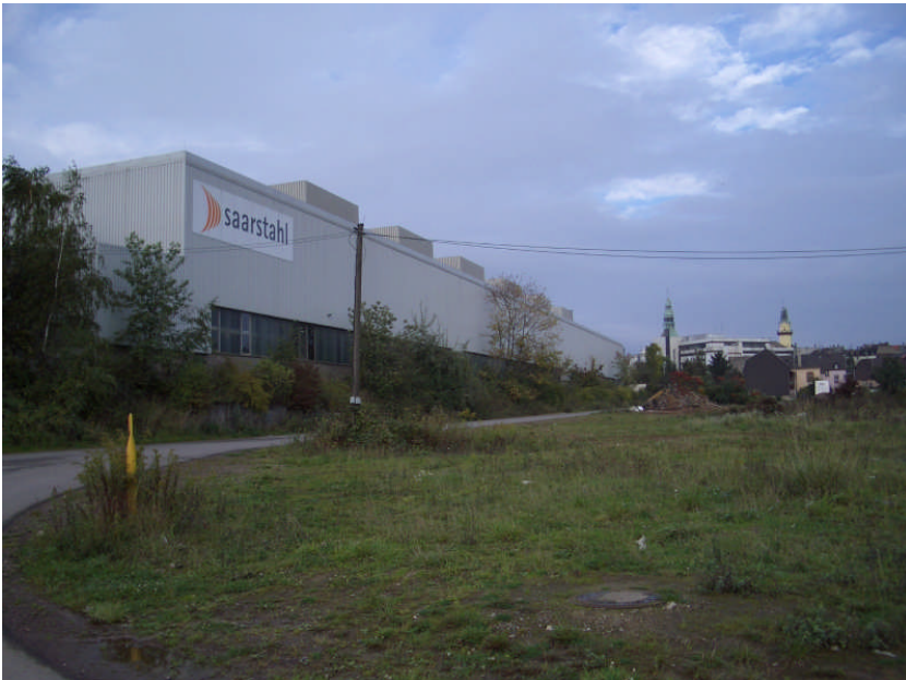
Hüttenhalle steht auf den Grundstücken der linken Saarstraße. Die Grundstücke der rechten Saarstraße sind Freifläche.
