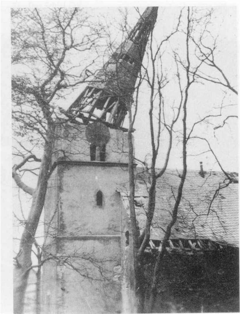
Die „Alte Kirche“ bei ihrem Abbruch im Jahre 1937
