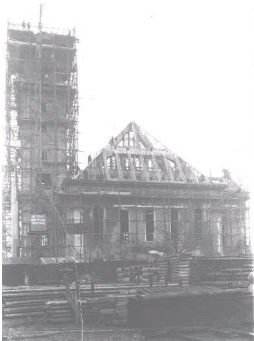
Kirche im Bau
