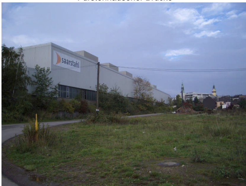
Hüttengelände „saarstahl“ an der früheren Saarstraße
