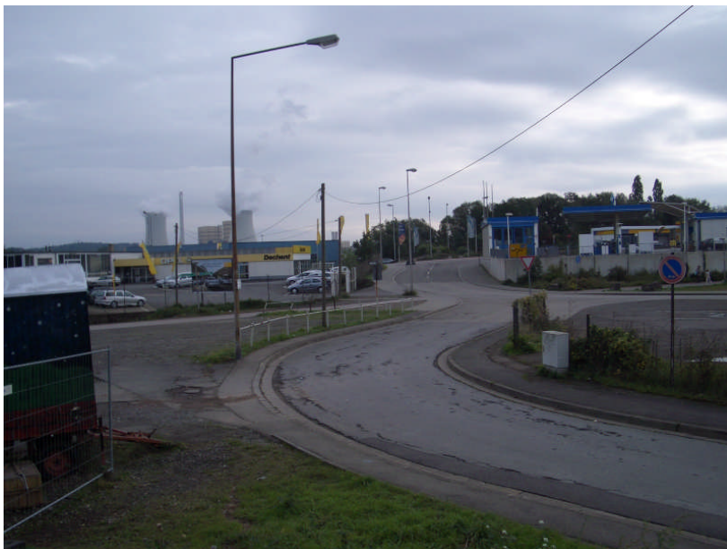
Im Hintergrund Kühltürme vom Kraftwerk Fenne.
